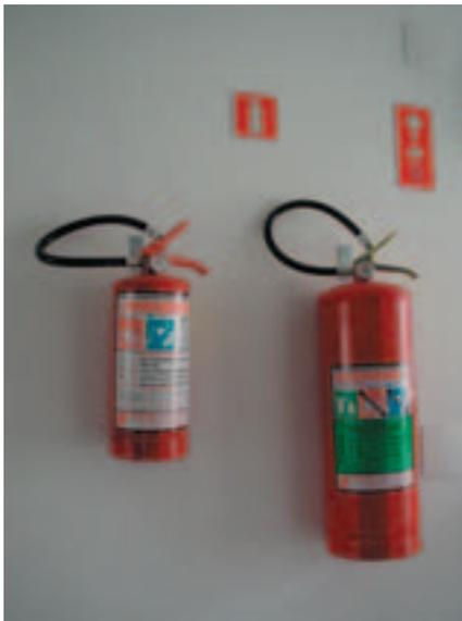
Figura 9 – Extintor de incêndio
