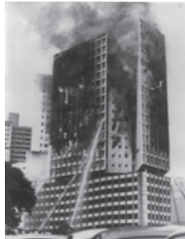
Figura 22 - Propagação por condução (contato direto das chamas)
