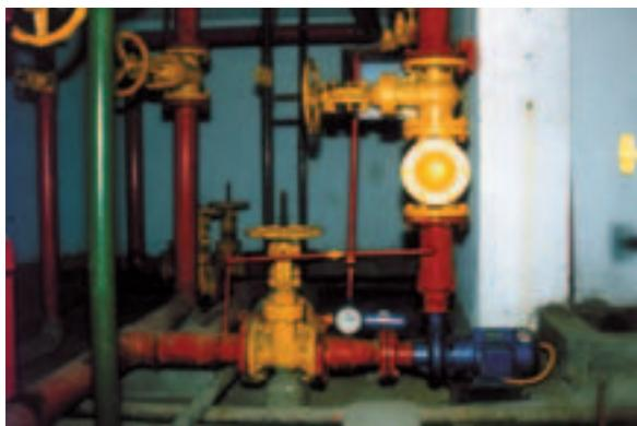
Figura 60 - Bomba de incêndio e acessórios hidráulicos
