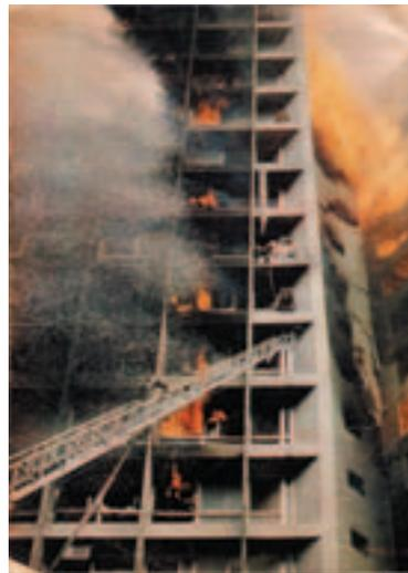
Figura 23 - Propagação por convecção, onde gases quentes fazem com que ocorra focos de incêndio em andares distintos
