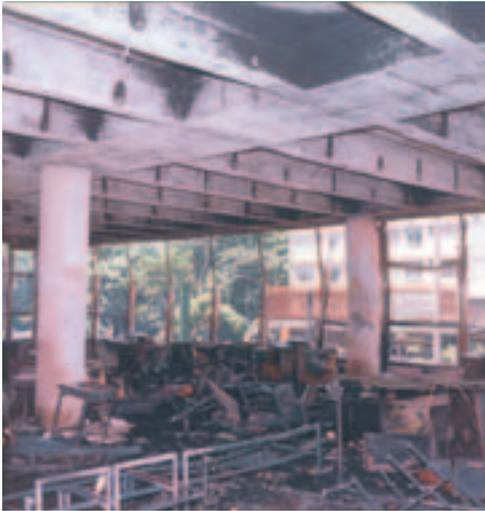
Figura 15 - Incêndio no pavimento
