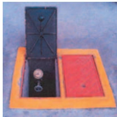
Figura 58 - Registro de recalque para bombeiros
